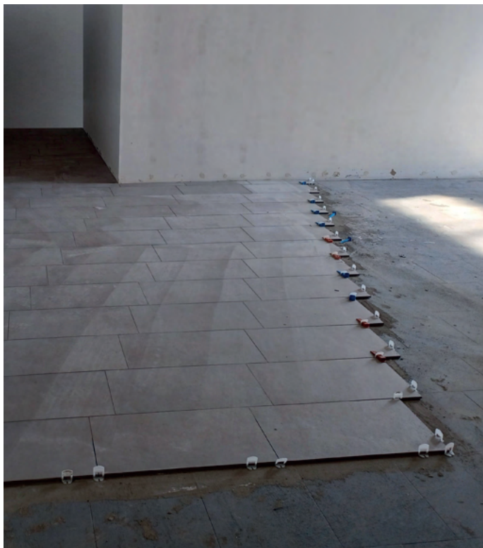
Fig. 6 - Exemplo de renovação de revestimento sobre cerâmica preexistente.
