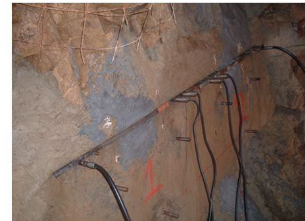
Macacos planos colocados para ensaio
