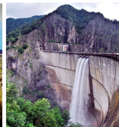
Vidraru Dam (Romania)
