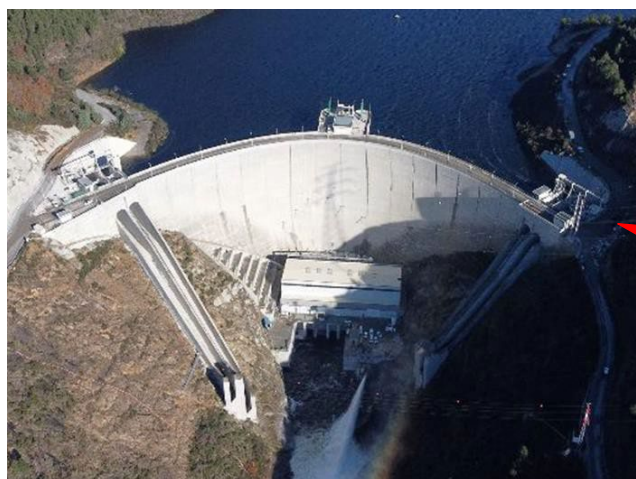
Barragem de Alto Tâmega
