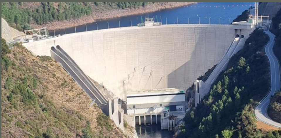
Barragem do Alto Tâmega
