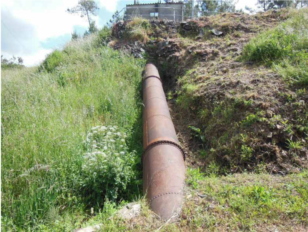
Tubería forzada
