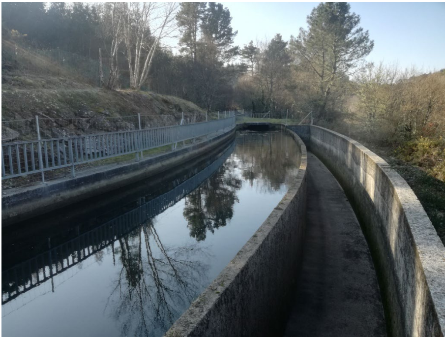
Cámara de carga
