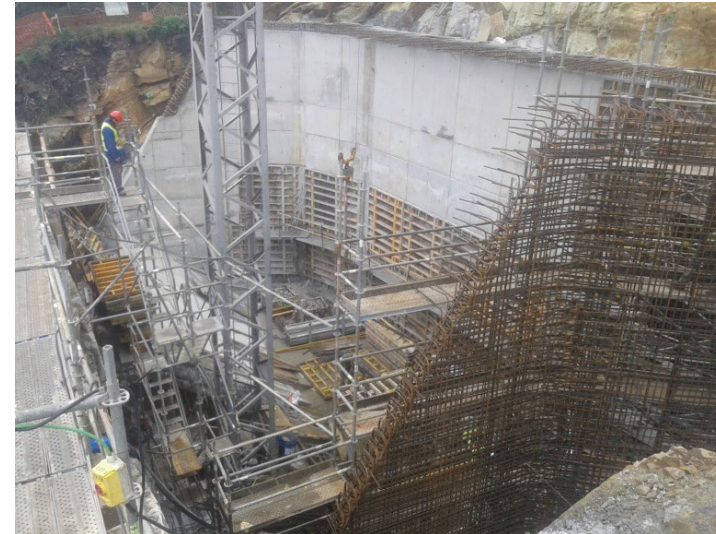
Construcción obra de toma. Proyecto CH Ponte Olveira
