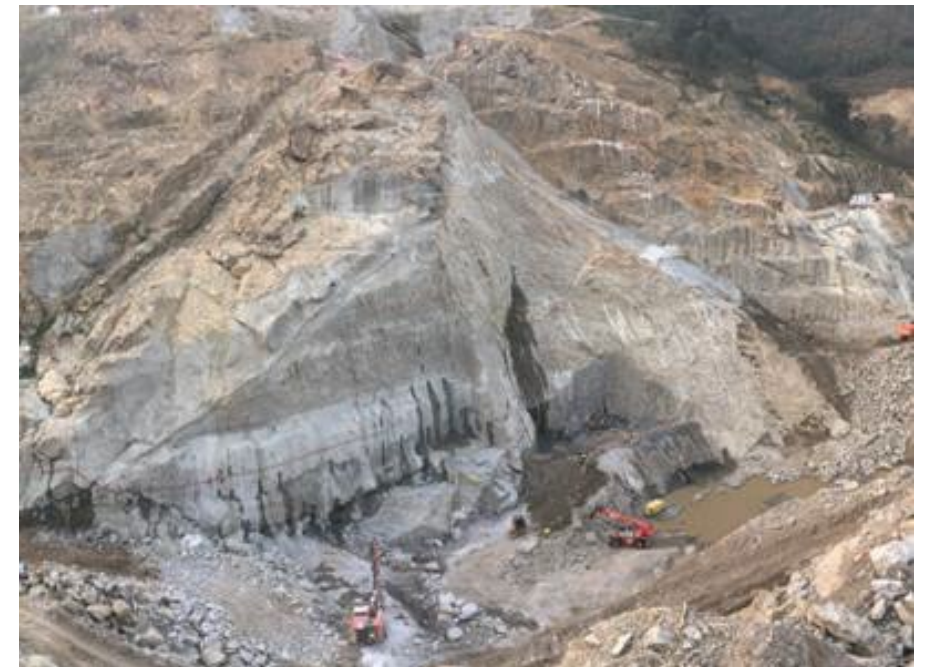
Depois de removidos os escombros
