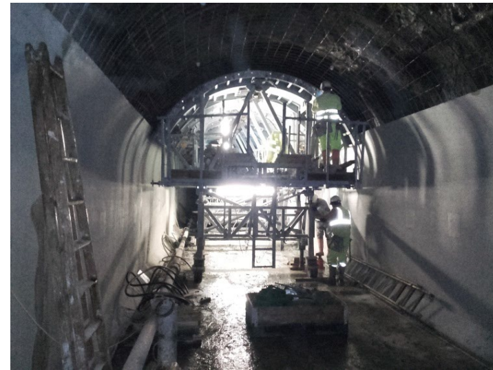
Revestimiento de túnel. Proyecto CH Ponte Olveira
