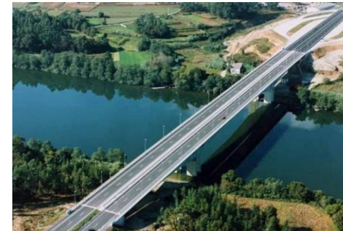
Ponte nova Tui-Valença
