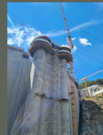
Torre das Comportas
