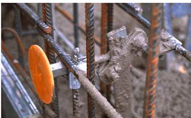
A transição do elétrodo de terra embebido nas fundações para os barramentos equipotenciais é realizada com um ponto fixo de terra instalado antes da cofragem.
