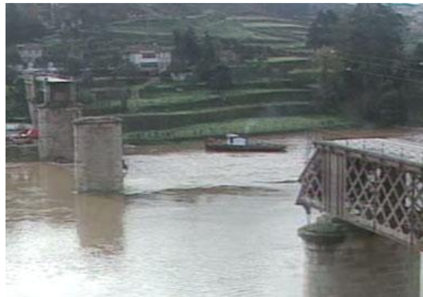
Colapso da ponte de Entre-os-Rios., em Castelo de Paiva (2001/03/05). Fonte:..Jornal Público (2001).
